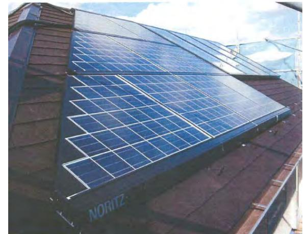
PV 14.8 m<sup>2</sup> (1.7 kW), 太陽熱 8 m<sup>2</sup>
