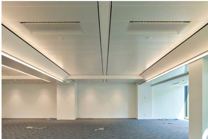
ダイナミックレンジ放射空調システム(6-8階)
