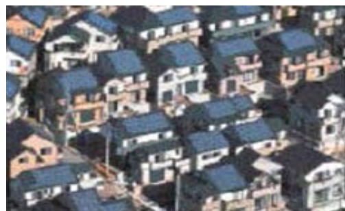
住宅屋根設置
