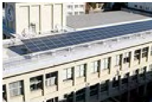
公共施設屋根設置
