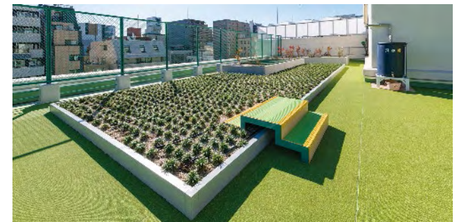
小学校における屋上緑化の事例
