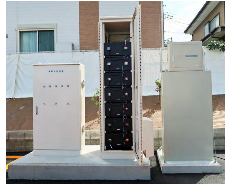
リユースバッテリーによる 店舗用蓄電池
