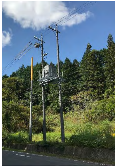
図 2 - 6 無効電力補償装置の例
